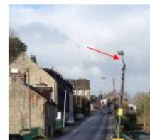
Rue Saint Hilaire (luminaire ayant reçu un choc)
